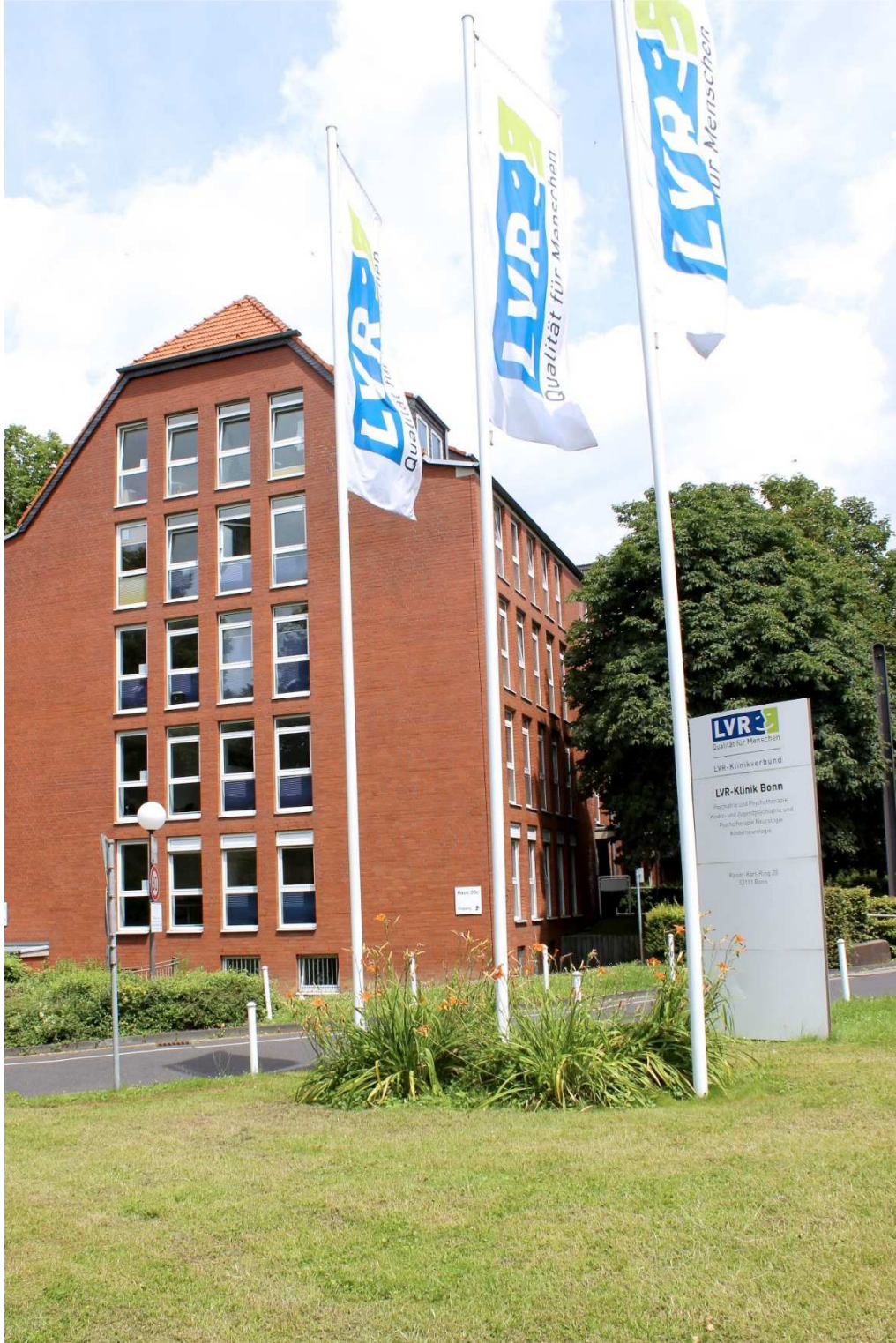
LVR-Klinik Bonn – Ambulanzgebäude Haus 20c
