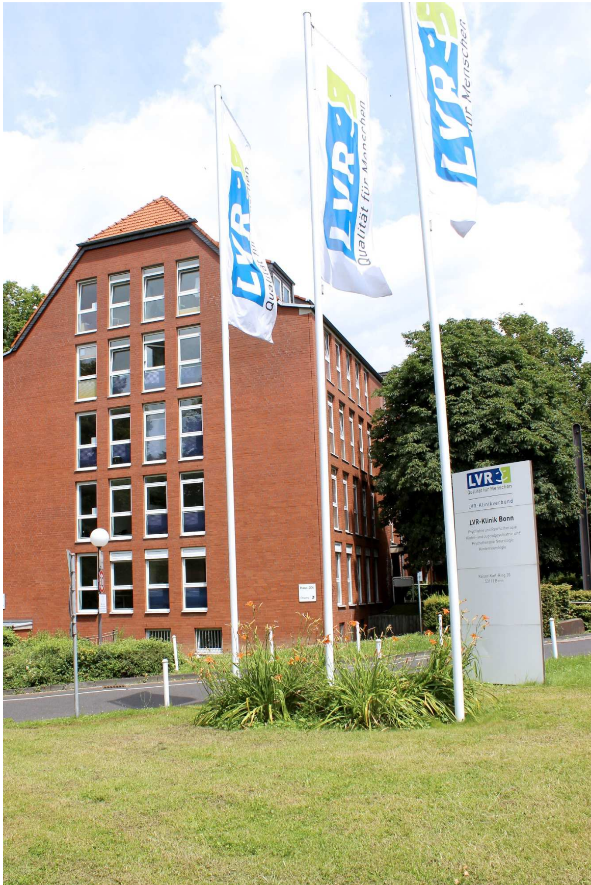
LVR-Klinik Bonn – Ambulanzgebäude Haus 20c
